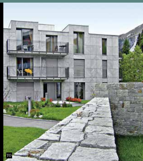
Unterschiedlich bearbeitet: sandgestrahlte Plattenfassade und bruchrohe Sichtschutzmauer aus San Bernardino Silber.
