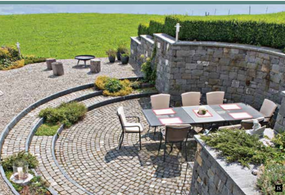
Einheitlicher Materialcharakter auf einem Gartensitzplatz: gesplattene und bossierte Guber Mauersteine für die Abschlussmauer, gesplattene Guber Pflastersteine für den Bodenbelag.
