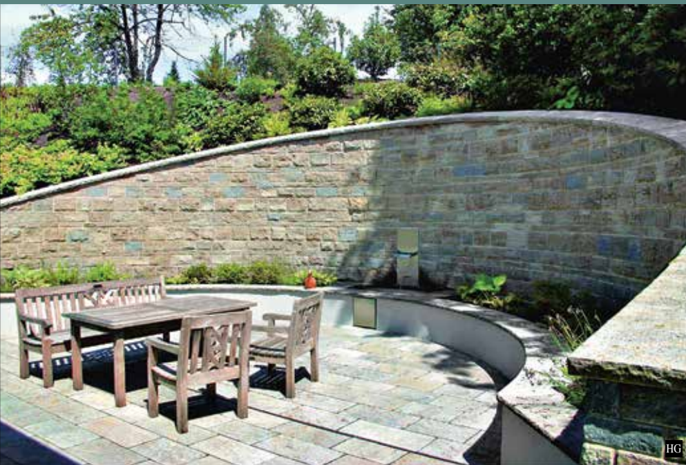
Ein Sitzplatz zum Geniessen: Schichtenmauerwerk mit Mörtelfuge und Bodenplatten in Bahnen aus Kirchheimer Muschelkalk.
