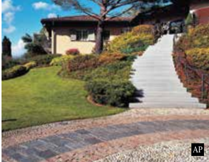
Bunter Materialmix mit gespaltenen Bodenplatten aus Calanca Gneis.
